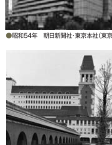
●昭和55年 倉敷市新庁舎(岡山)
