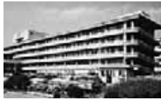
●昭和38年 慶応病院中央棟(東京)
