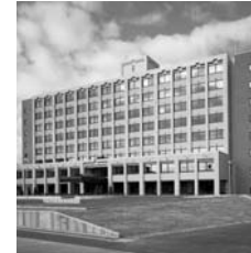
●昭和63年 札幌大学中央棟(北海道)
