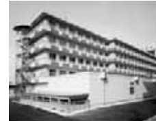
●昭和63年 福井日本赤十字病院新棟(福井)
