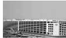
●昭和48年 東京流通センター 物流ビル(東京)
